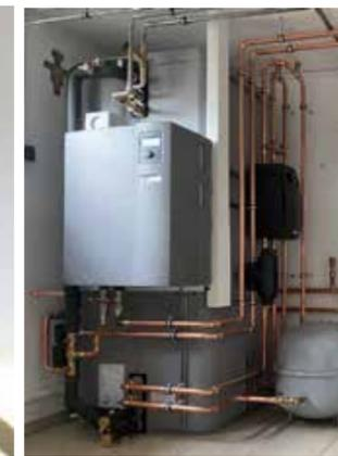
Montagebeispiel mit Anschluss-Set und Hydraulikmodul
